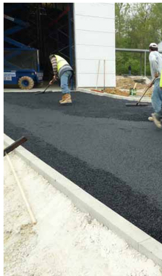
Finišery pracují při pokládce asfaltu pro nové skladovací prostory.
